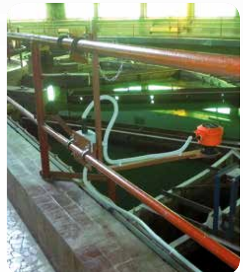
Erőmű- ipari vízkezelő mű szintmérés
