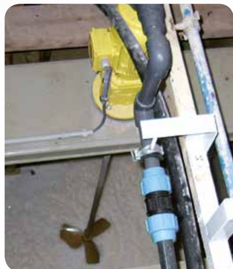
Mosószergyár szennyvízkezelés- keverő
