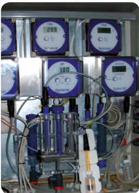
Mosószergyár pH és klórmérés
