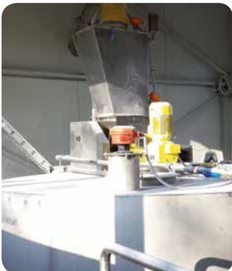
Poradagoló szintmérés
