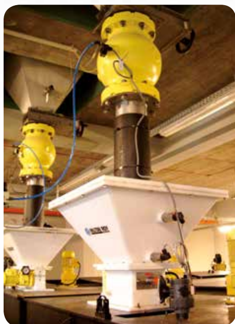
Szennyvíztelep- polimer por elzárása
