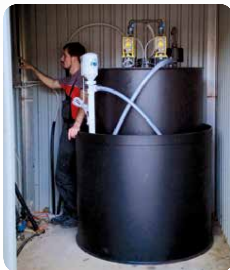
Szennyvíztelep- hypo átfertése
