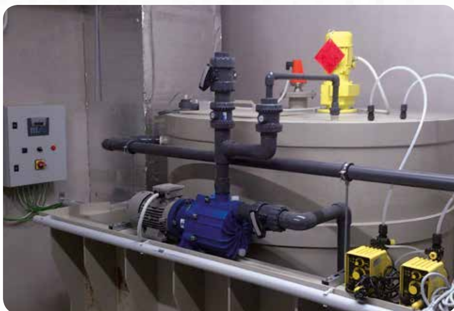
Gyógyszeripari labor- szennyvízsemlegesítés
