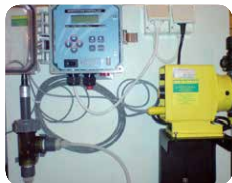
Borászat palack fertőtlenítés-WDIS műszer
