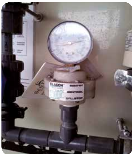
Vegyszeradagoló állomás- elválasztott manométer
