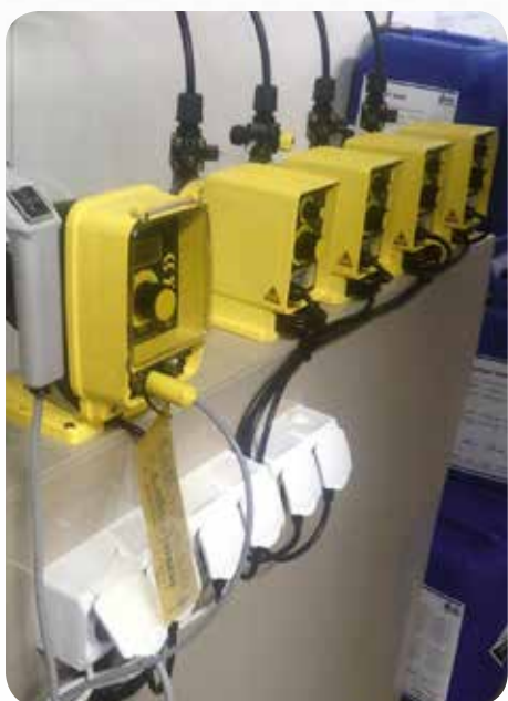
Hűtőtorony vízkezelés-biocid adadolás
