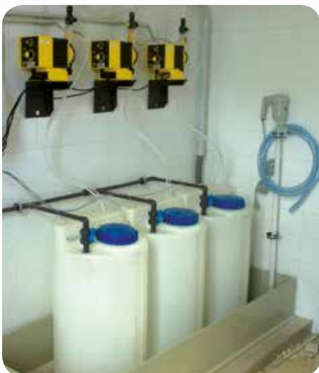
Csatornázási művek- hypo átfertés
