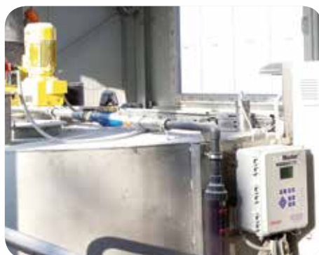
Ipari szennyvíz semlegesítés-WIND műszer
