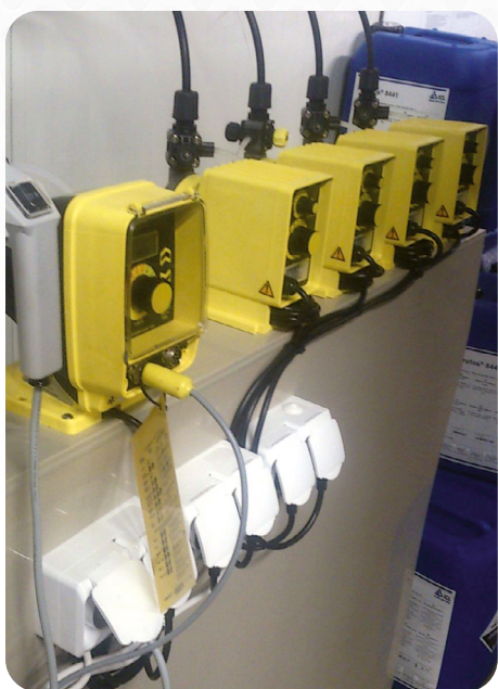
Hűtőtorony vízkezelés-biocid adagolás
