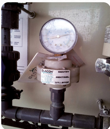
Vegyszeradagoló állomás- elválasztott manométer
