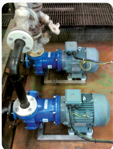
Sósav átfajtése erőművi alkalmazás
