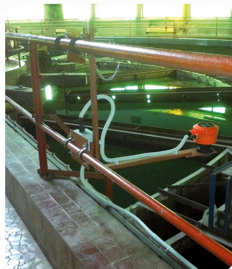
Erőmű- ipari vízkezelő mű szintmérés
