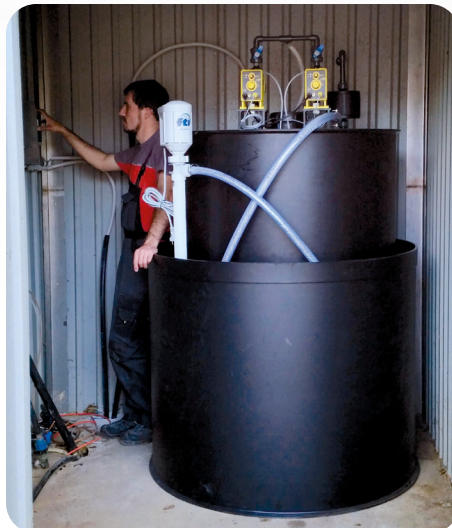
Szennyvíztelep- hypo átfajtése
