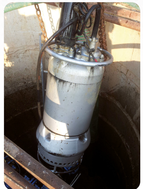
Homokkal szennyezett víz átemelése
