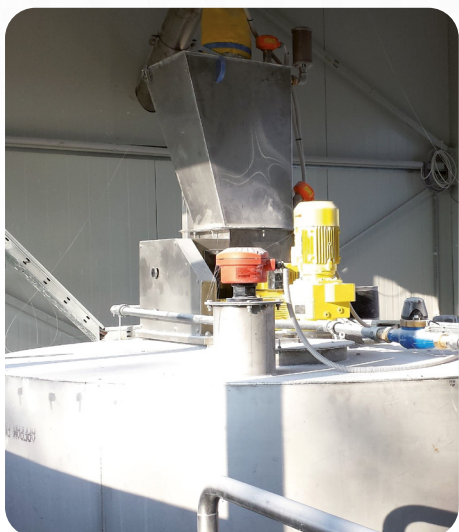
Poradagoló szintmérés
