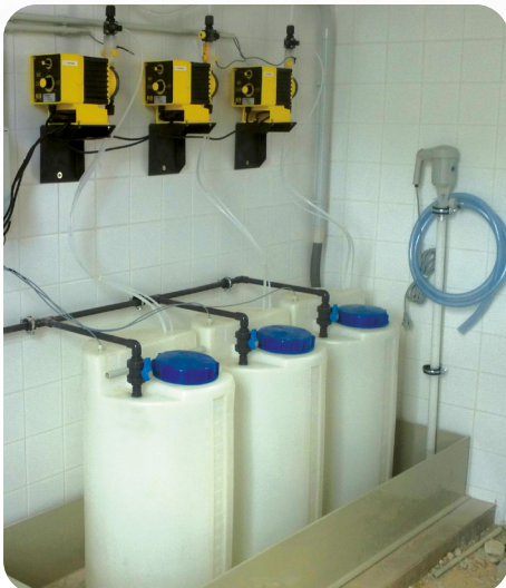
Csatornázási művek- hypo átfajtés
