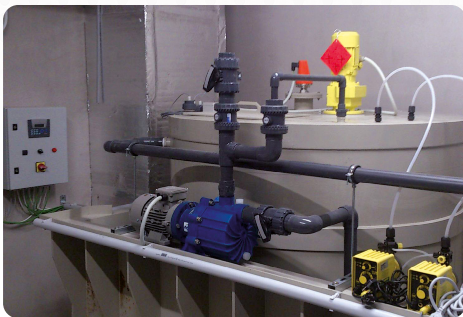
Gyógyszeripari labor- szennyvízsemlegesítés
