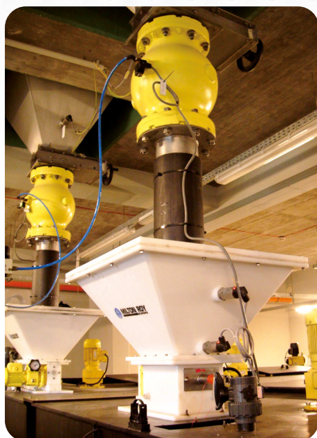
Szennyvíztelep- polimer por elzárása
