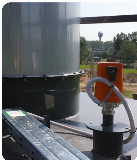
Gyümölcsfeldolgozó- mészhidrát siló szintmérés
