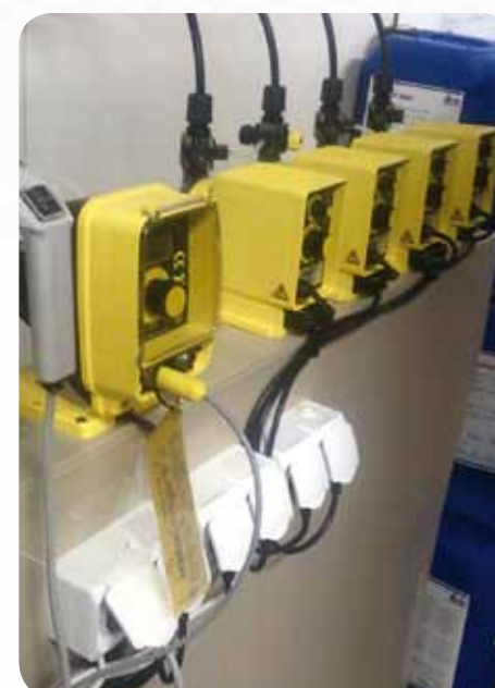
Hűtőtorony vízkezelés- biocid adagolás
