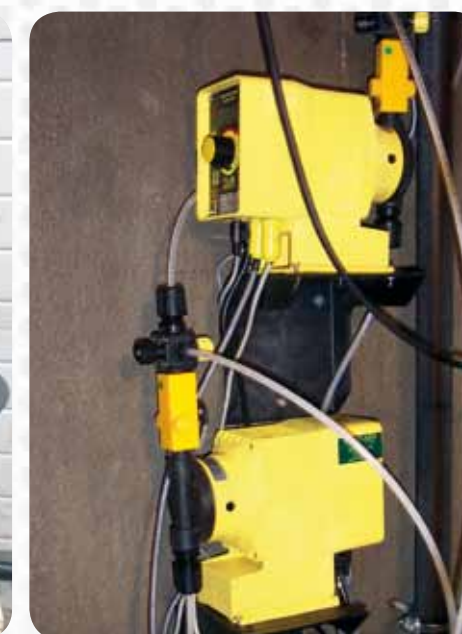
Uszodai vízkezelés- hidrogén-peroxid adagolása
